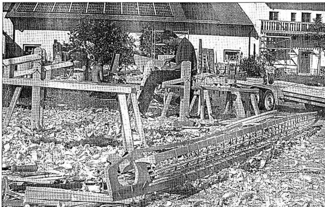
So soll das Gerippe des Baidaraks einmal aussehen. Doch bis dahin müssen die Teilnehmer am Workshop noch viel Arbeit leisten.
